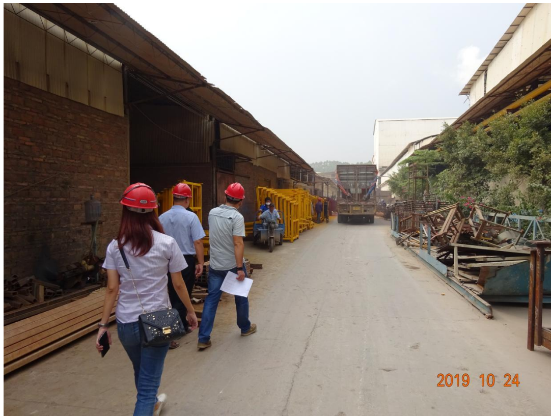
现场勘察影像：
