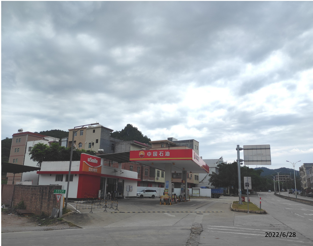
中国石油天然气股份有限公司广东云浮罗定莘塘加油站现场勘察影像：
