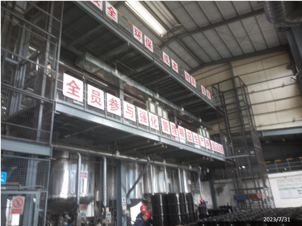
南雄市沃太化工有限公司现场勘察影像：
