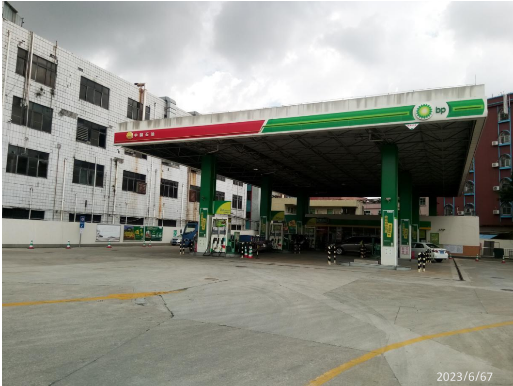
中油碧辟石油有限公司东莞加岭加油站现场勘察照片：
