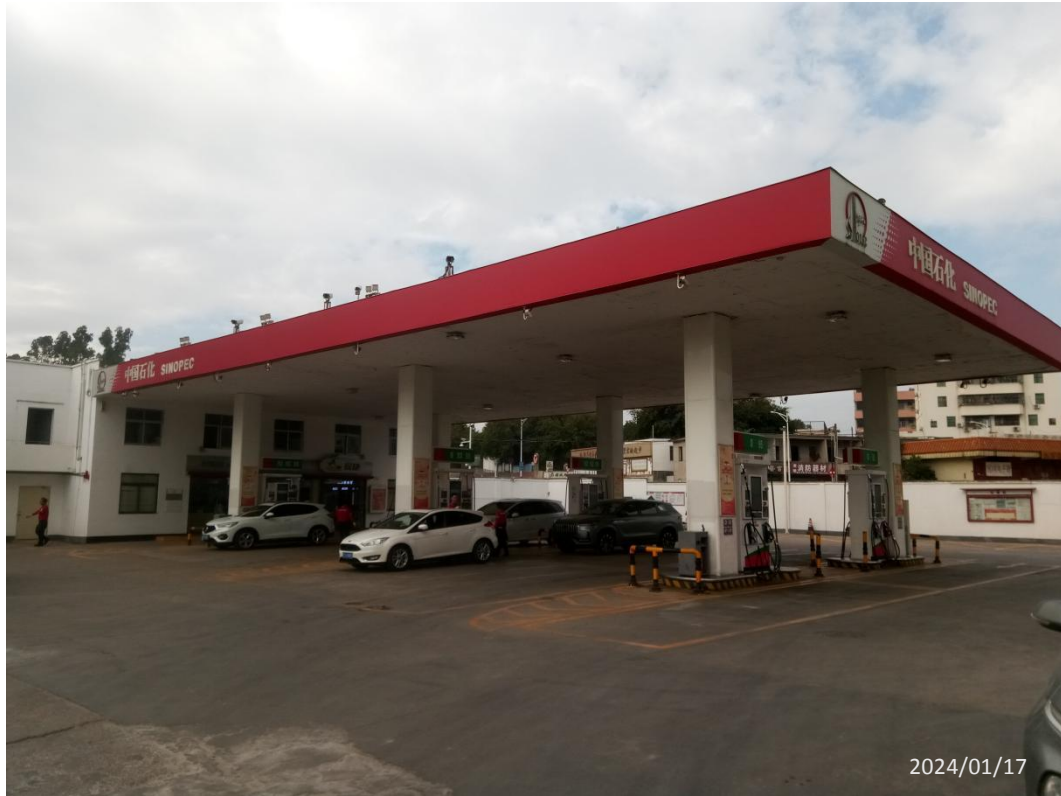
中国石化销售股份有限公司广东深圳辅城加油站现场勘察照片：
