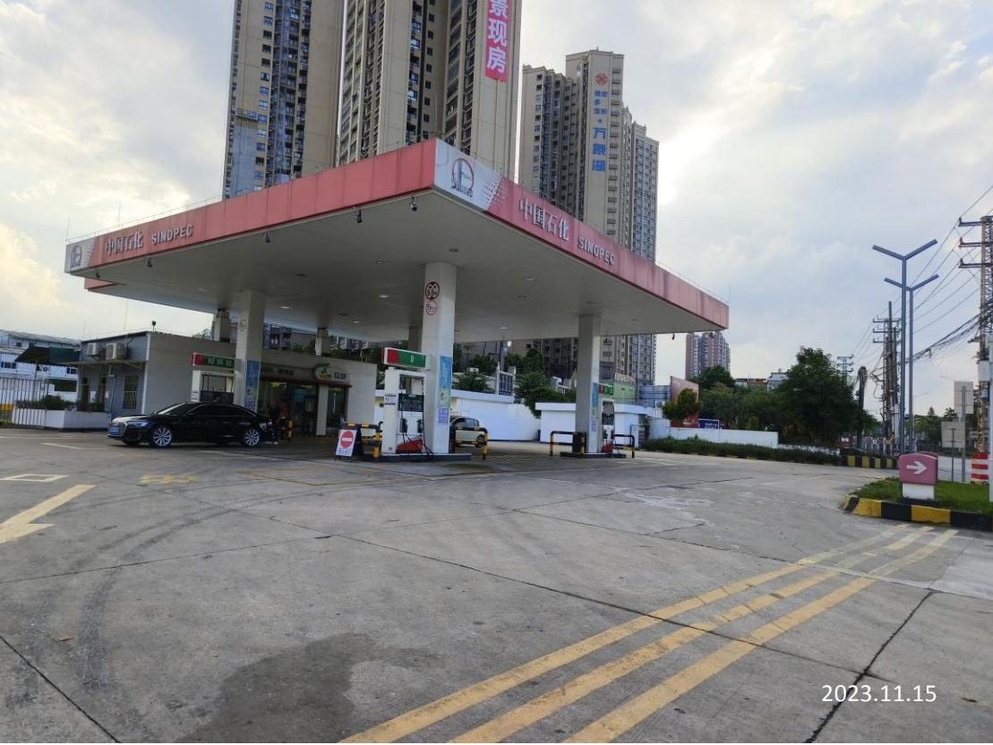
中国石化销售股份有限公司广东惠州华安加油站现场勘察影像：
