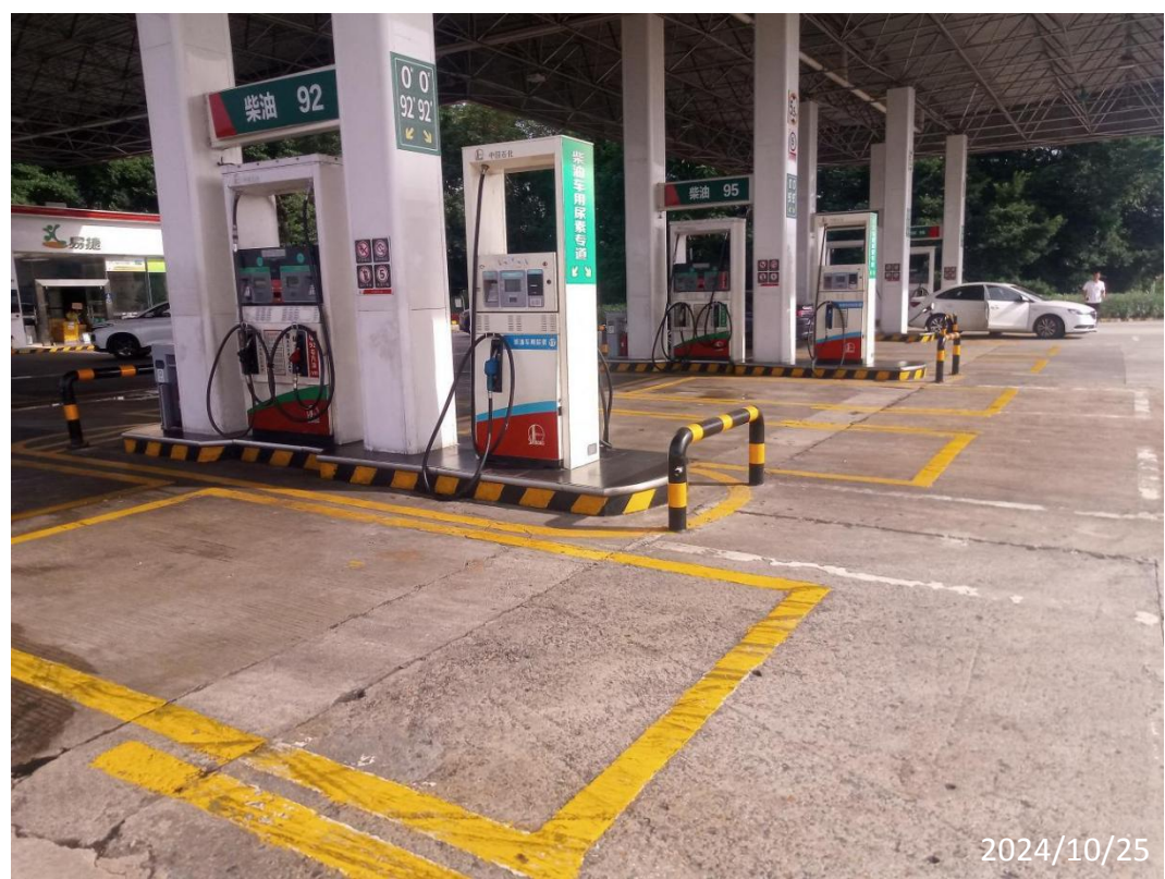
广东通驿高速公路服务区有限公司茂名市电白区服务区东站现场勘察照片：
