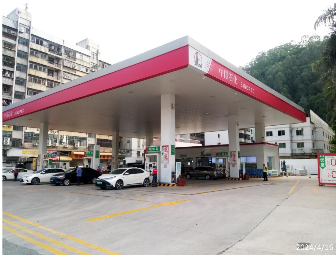
中国石化销售股份有限公司广东惠州惠南加油站现场照片
