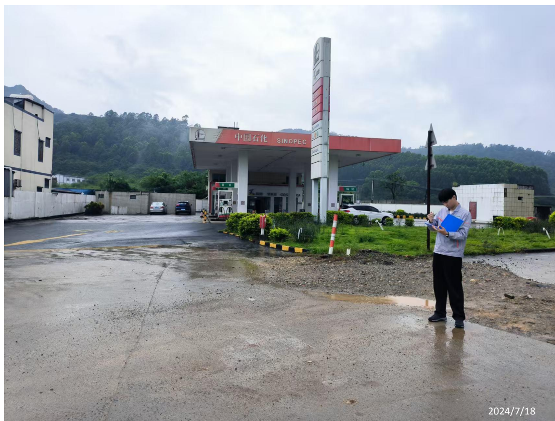
中国石化销售股份有限公司广东惠州惠东碧山加油站现场照片
