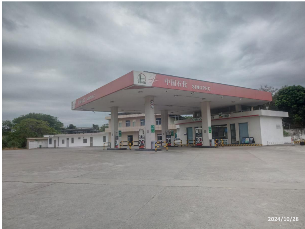
中国石化销售股份有限公司广东惠州惠东白云加油站现场照片
