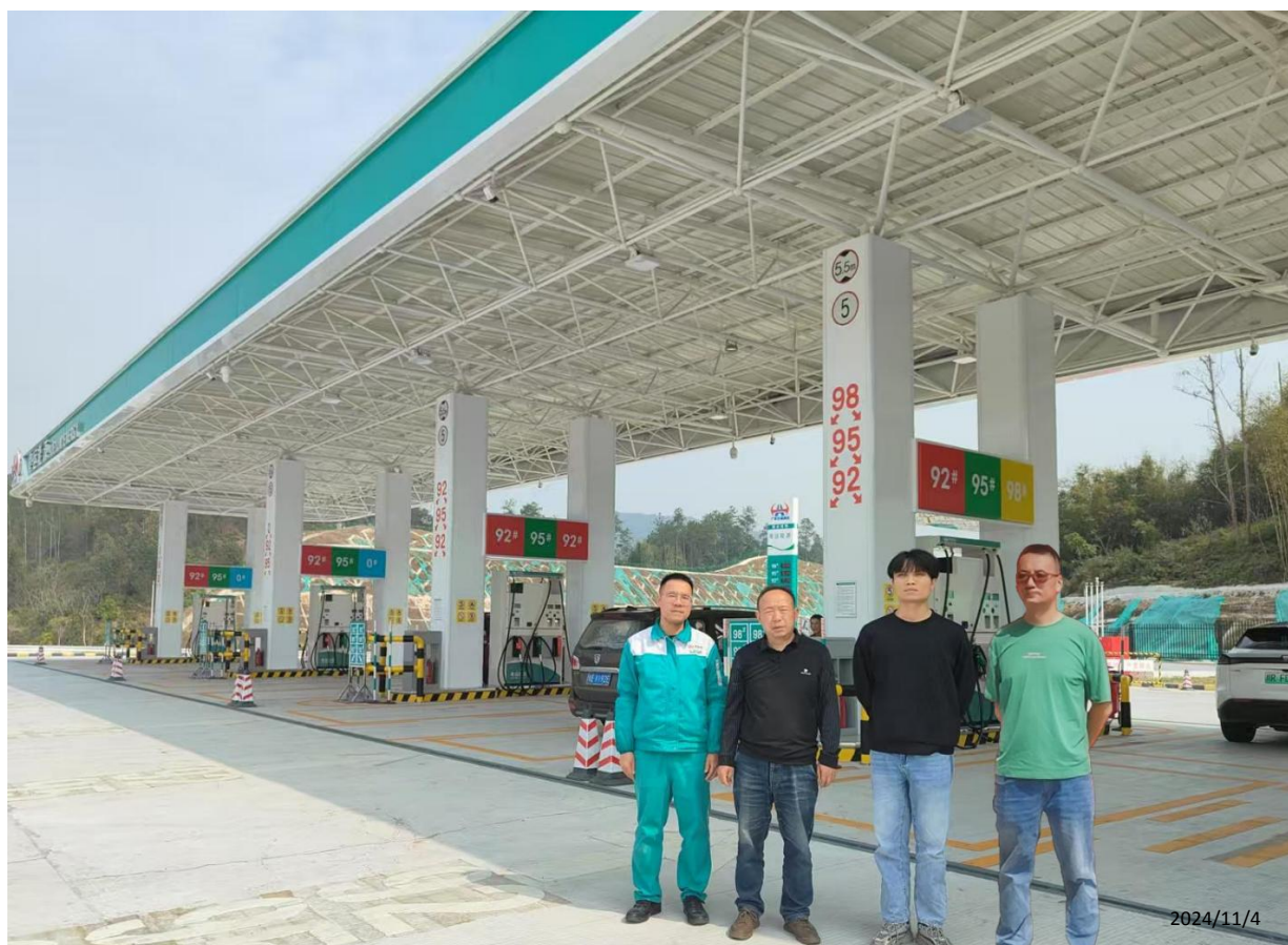
广东通驿高速公路服务区有限公司四会黄田服务区南区加油站现场勘察影像：
