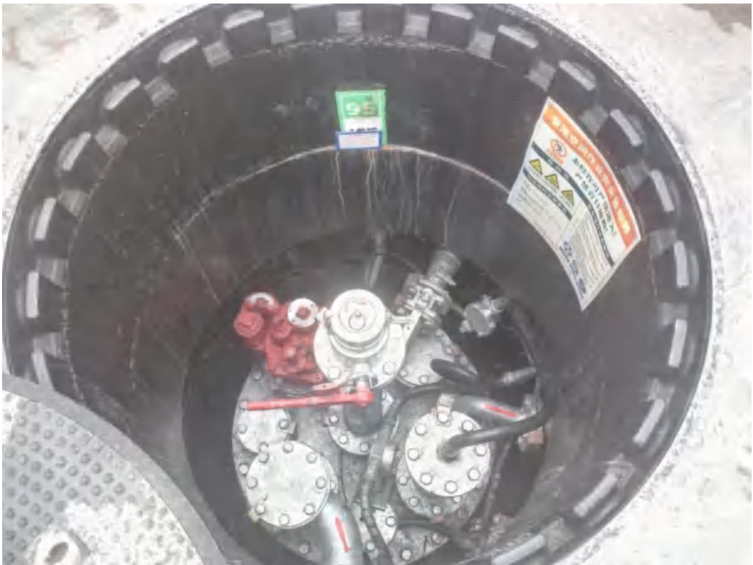
油罐人孔操作井图片
