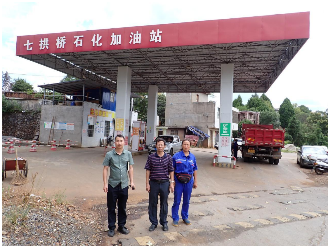
图 1：评价人员现场勘察图片一
