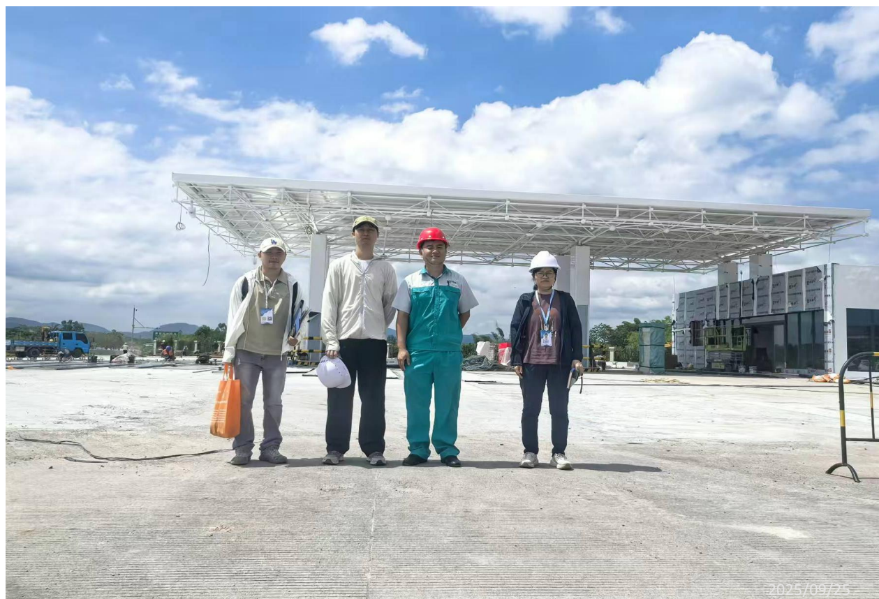
广东通驿高速公路服务区有限公司罗平服务区南区加油站现场勘察影像：
