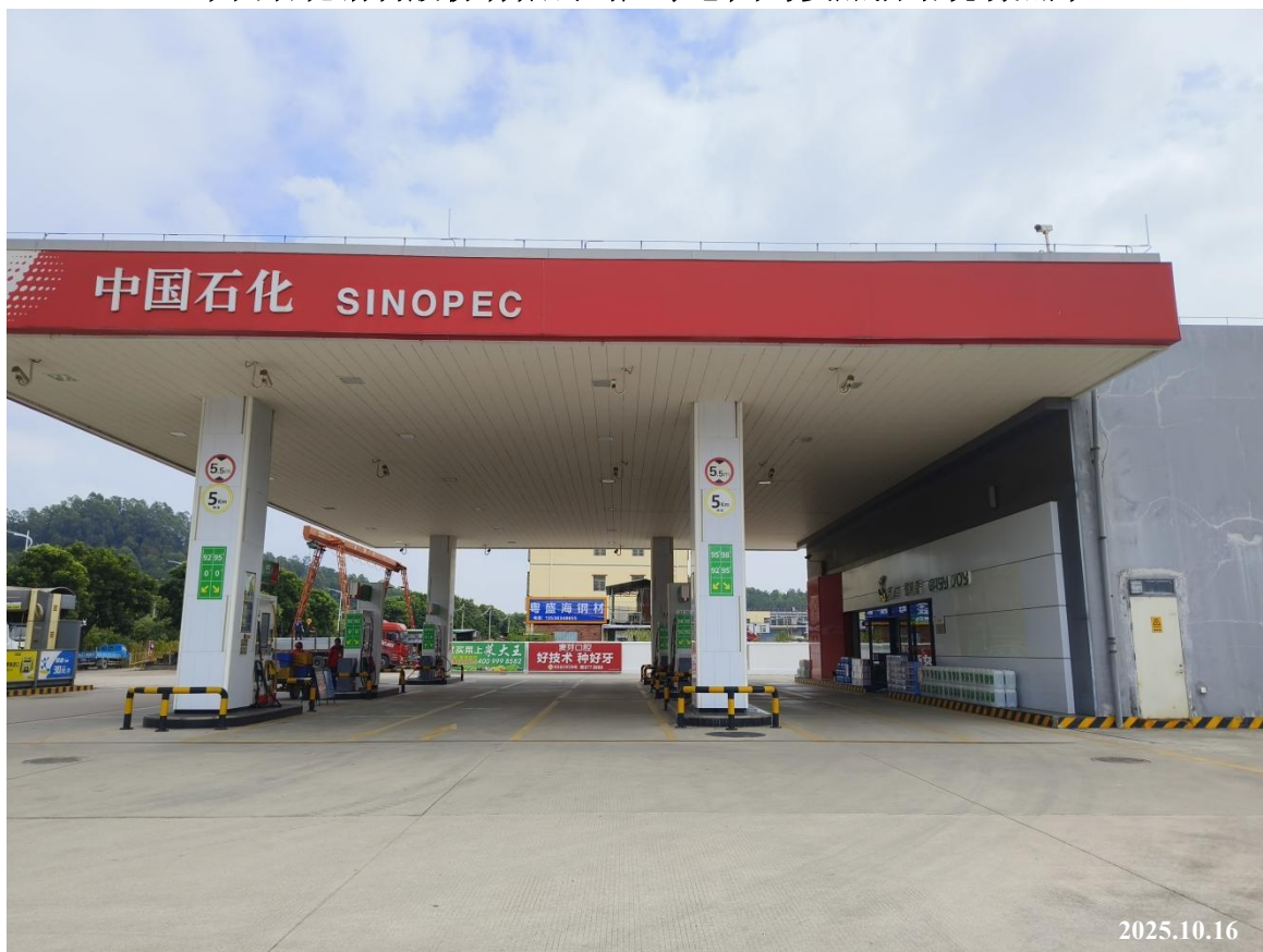
中国石化销售股份有限公司广东惠州马安加油站现场照片
