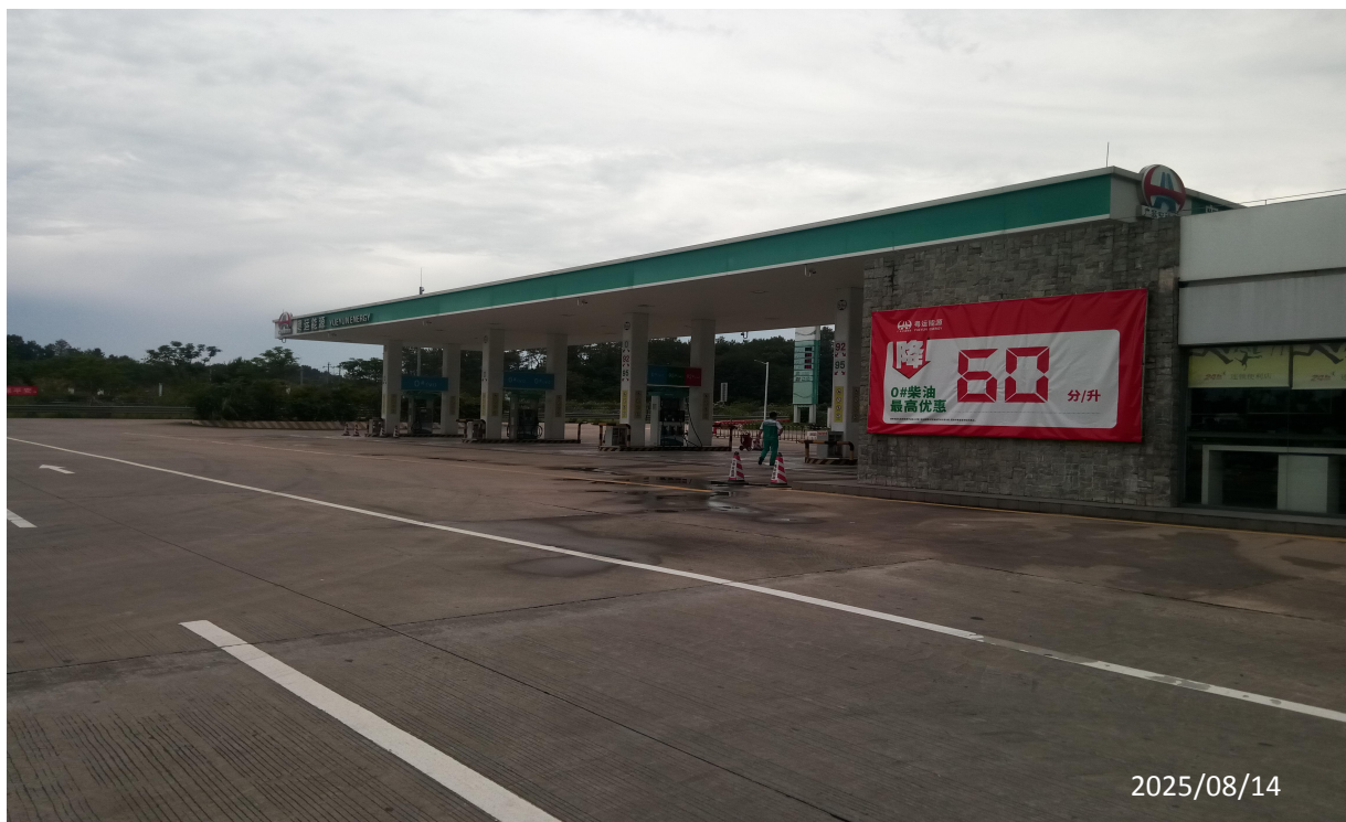
广东通驿高速公路服务区有限公司封开服务区北区加油站现场照片
