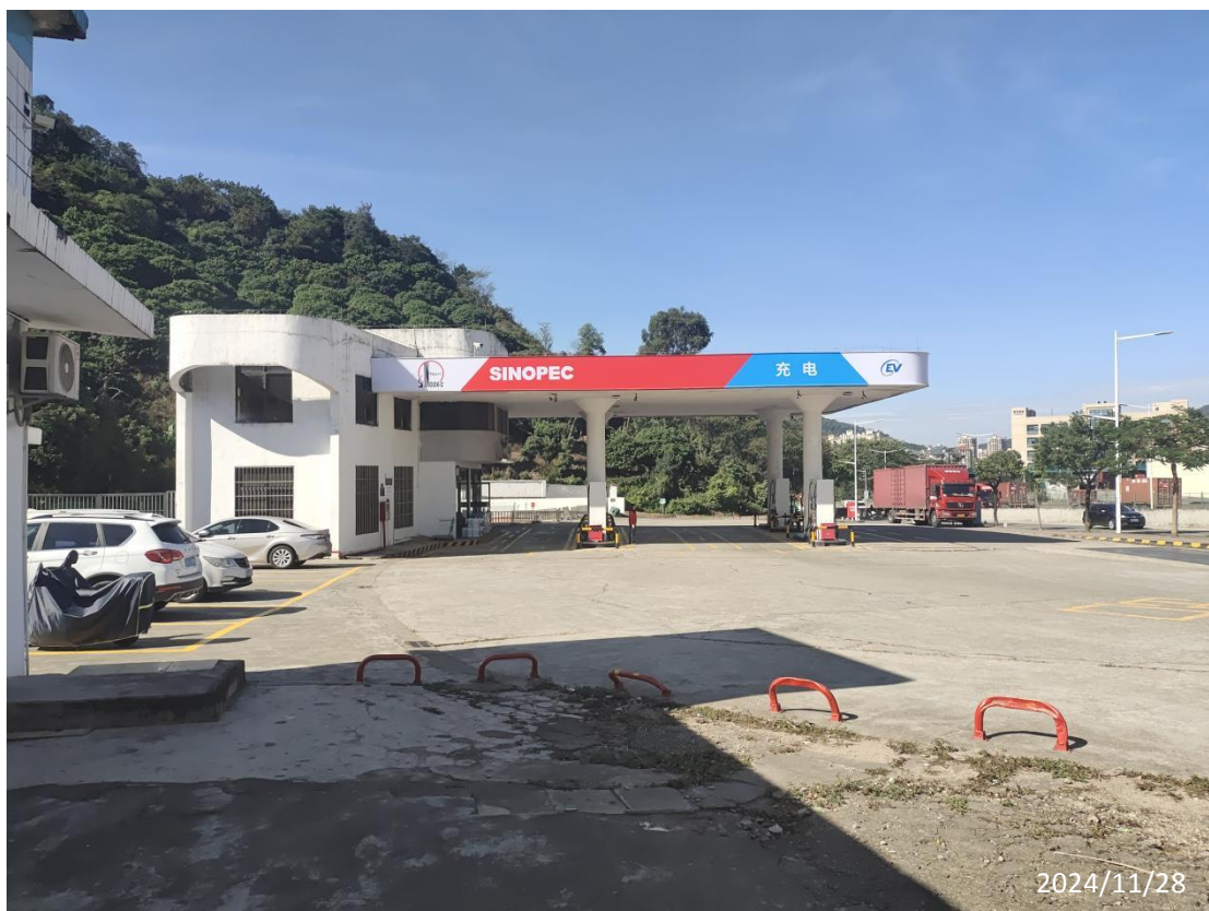
中国石化销售股份有限公司广东东莞樟木头新桥加油站现场照片
