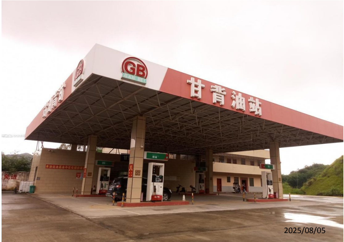
东源县回龙甘背加油站有限公司现场照片
