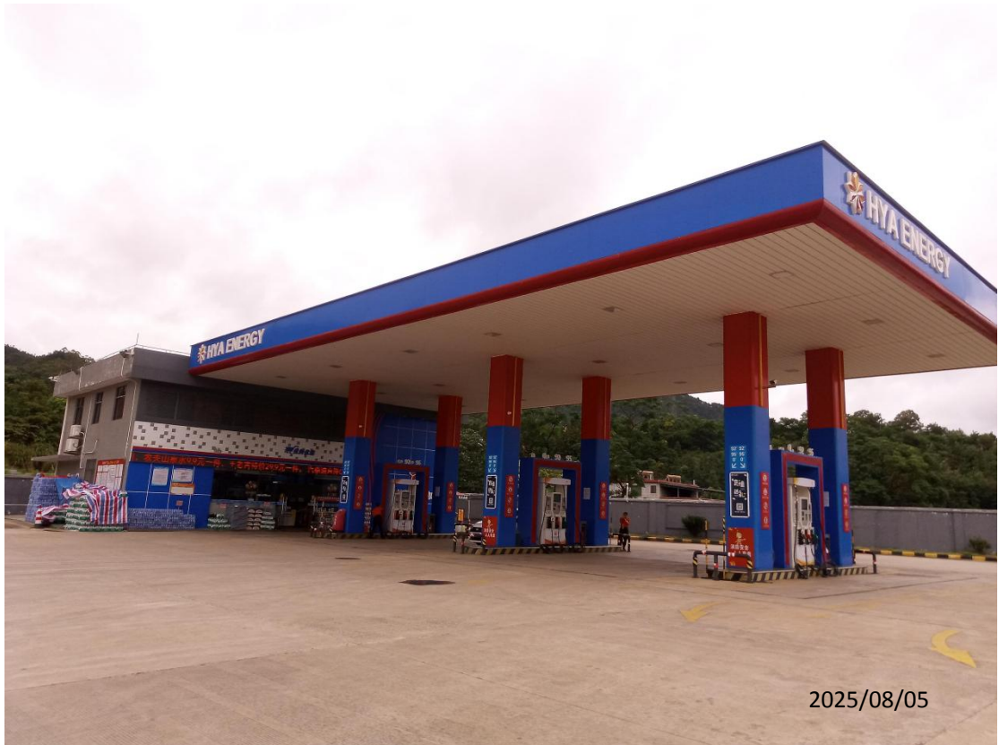
和平县博隆贸易有限公司龙湖加油站现场照片
