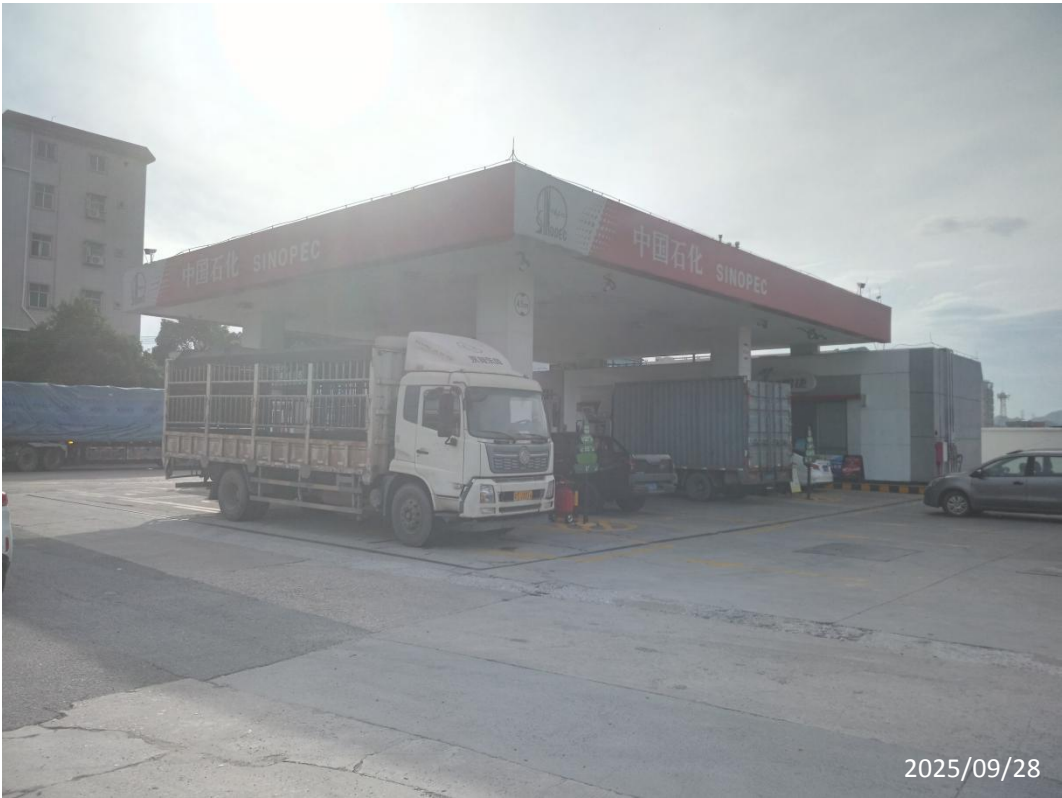
中国石化销售股份有限公司广东东莞大岭山大塘朗加油站现场照片
