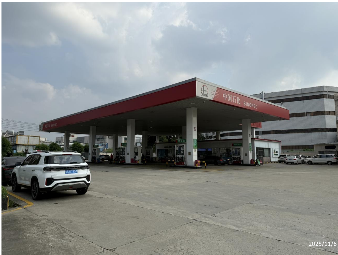
中国石化销售股份有限公司广东东莞寮步横坑加油站现场勘察影像：
