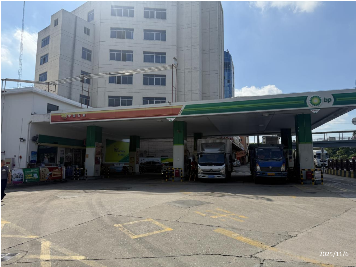
中油碧辟石油有限公司东莞明华加油站现场勘察影像：
