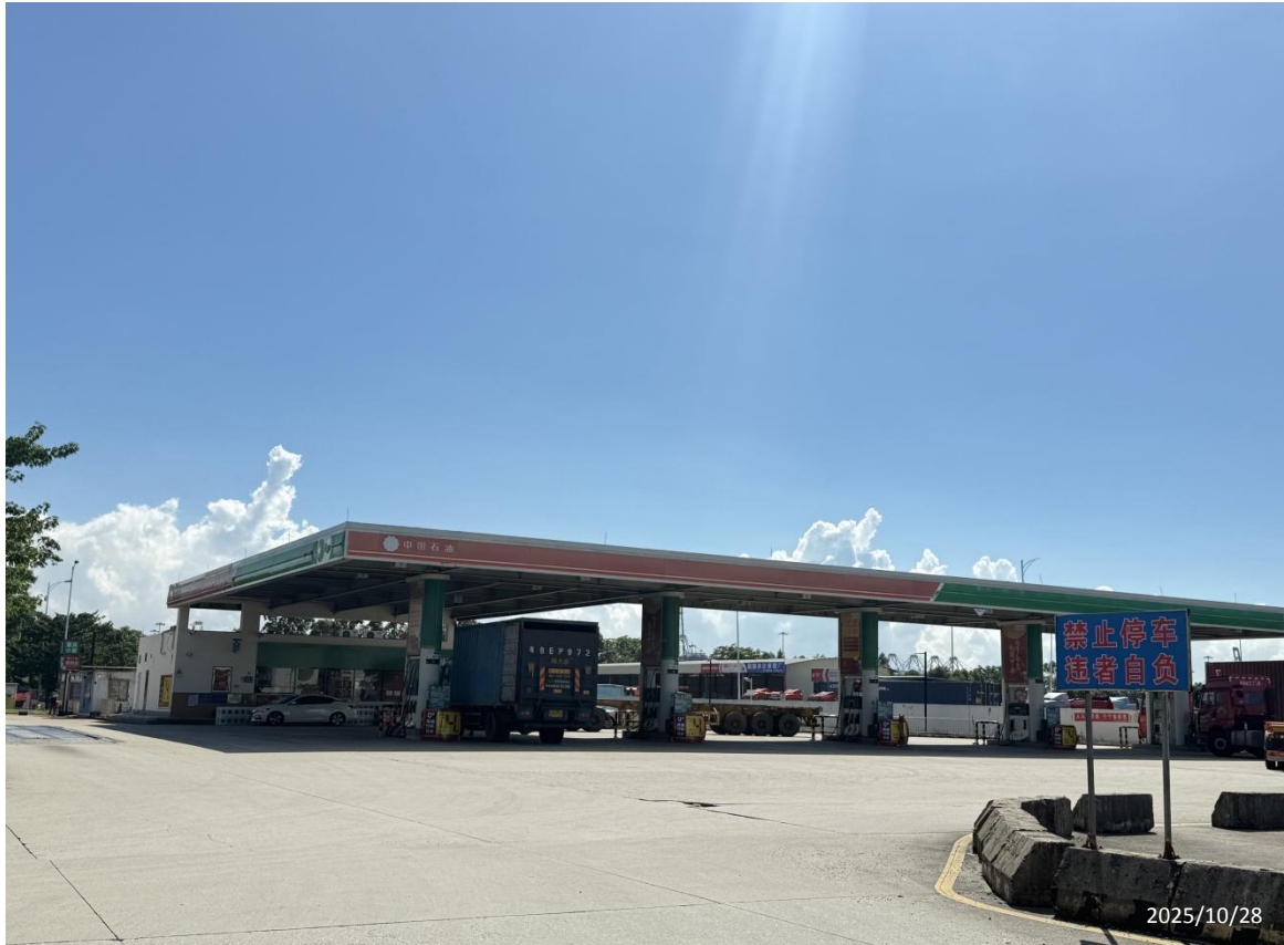
中油碧辟石油有限公司南沙港加油站现场勘察影像：
