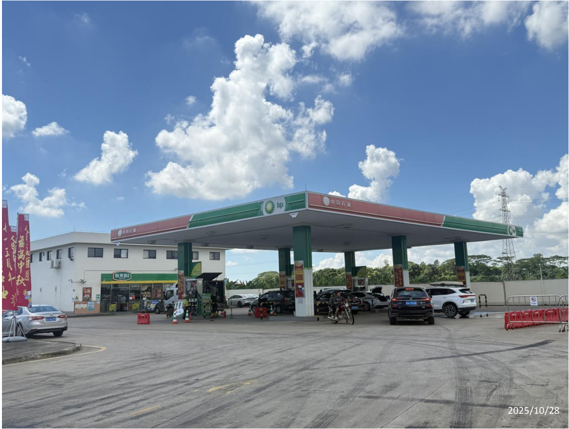
中油碧辟石油有限公司沙尾加油站现场勘察影像：
