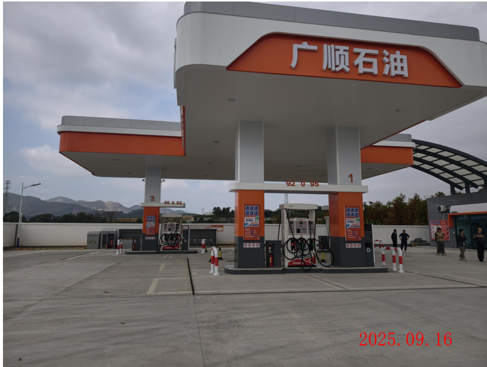
江门市新会区广顺石油有限公司加油站扩建项目验收评价现场勘察影像：
