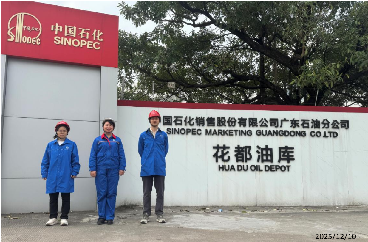
中国石化销售股份有限公司广东广州花都油库分公司现场勘察影像：
