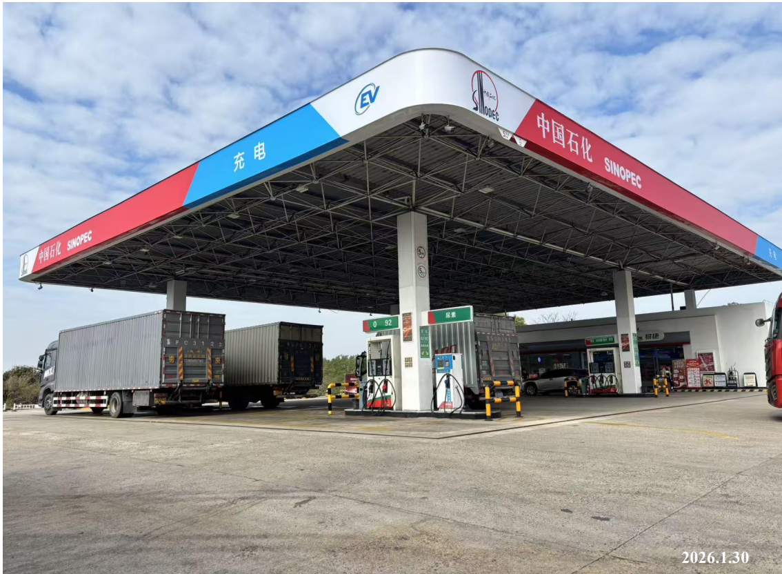
中国石化销售股份有限公司广东惠州惠阳良井北加油站现场照片
