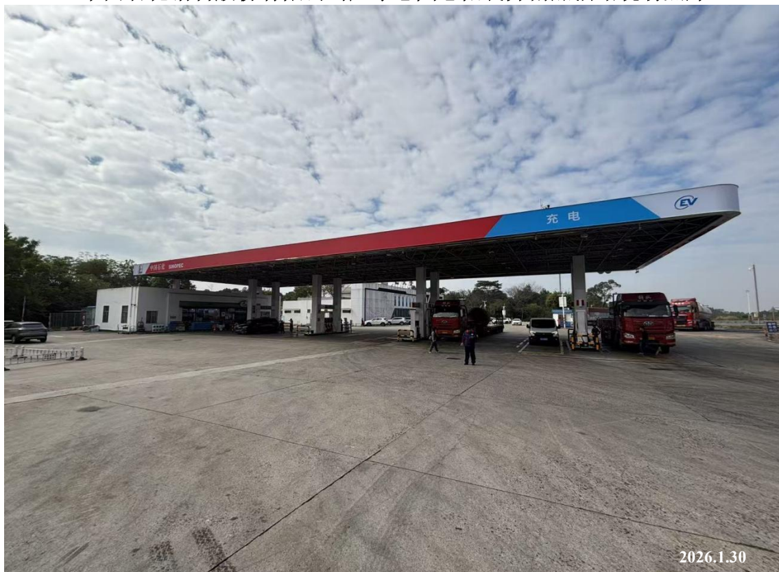
中国石化销售股份有限公司广东惠州惠阳良井南加油站现场照片
