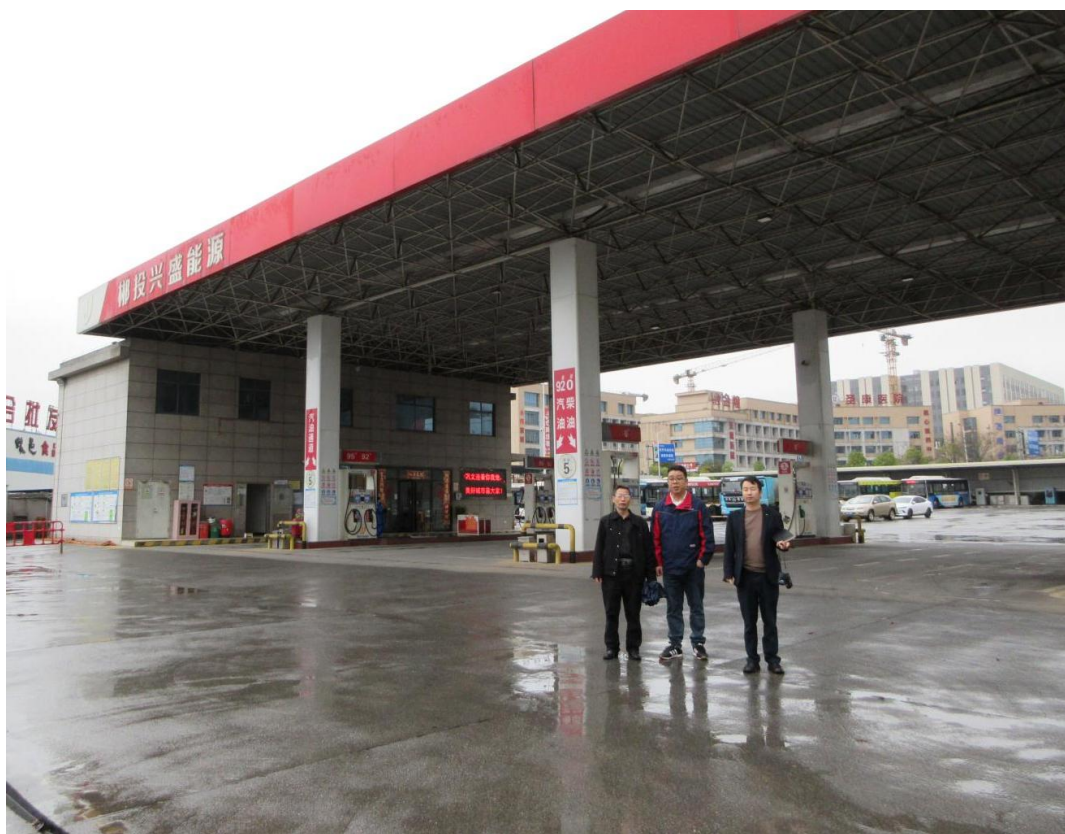
图 2：评价人员现场勘察照片
