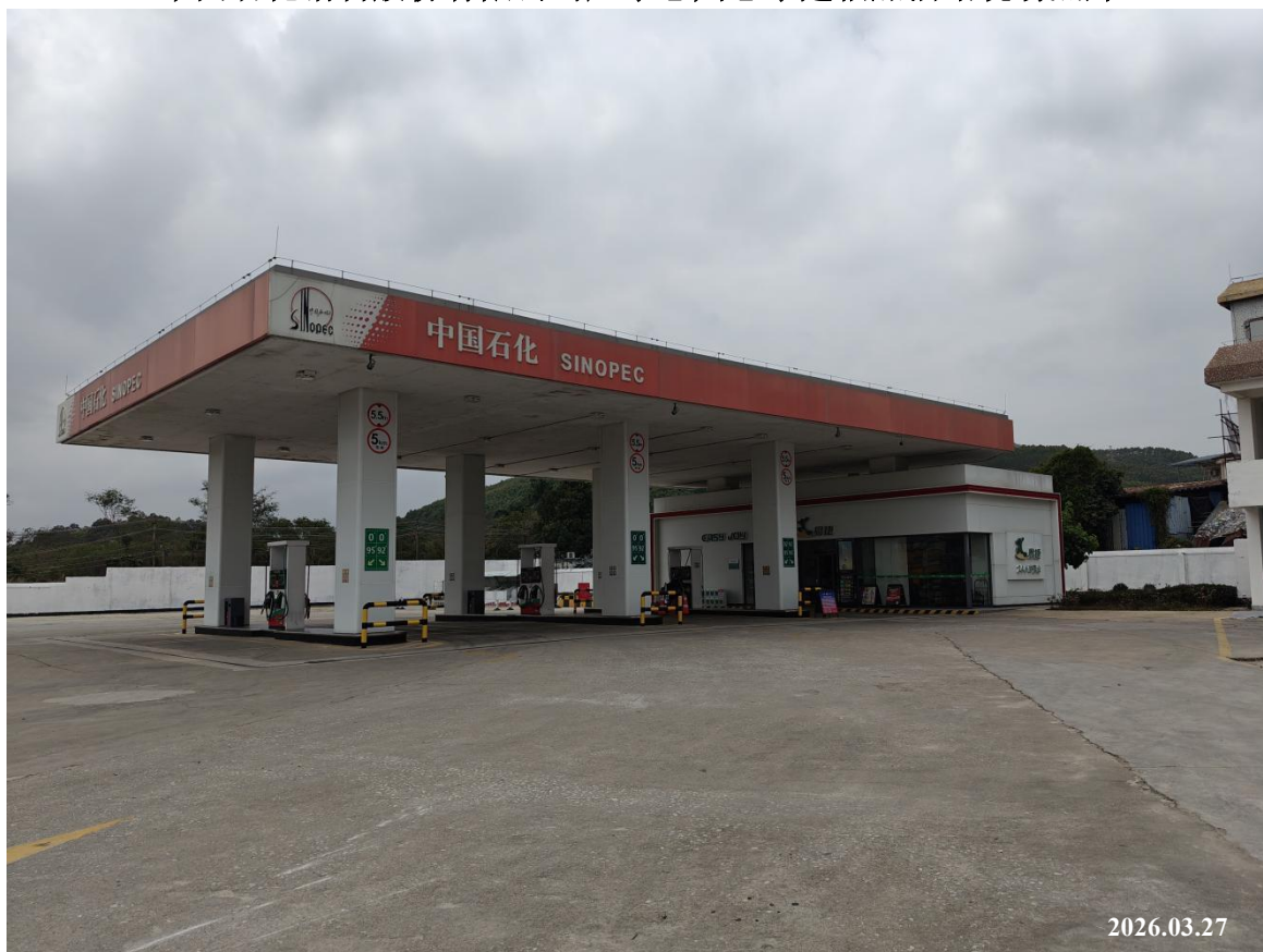
中国石化销售股份有限公司广东惠州惠东建福加油站现场照片
