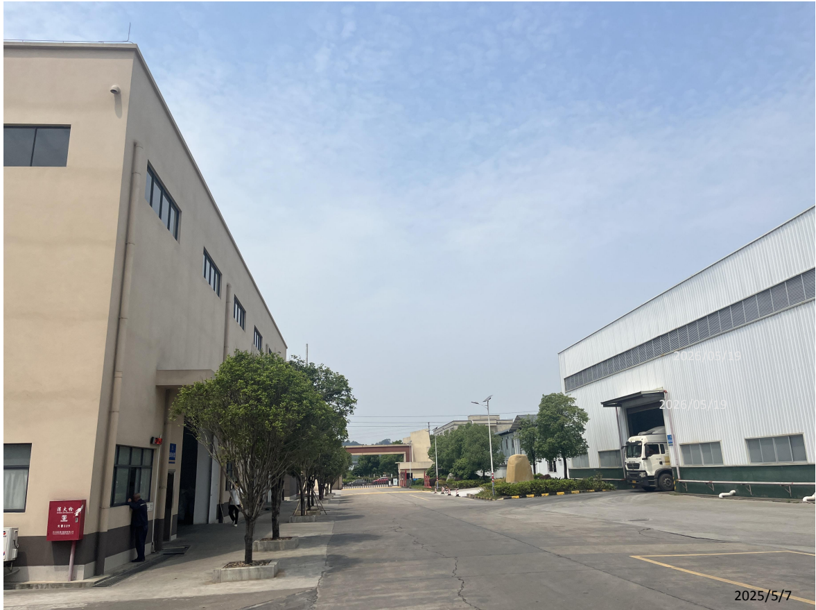
广东威玛新材料股份有限公司综合利用废动力锂电池粉料技术改造项目现场勘察影像：
