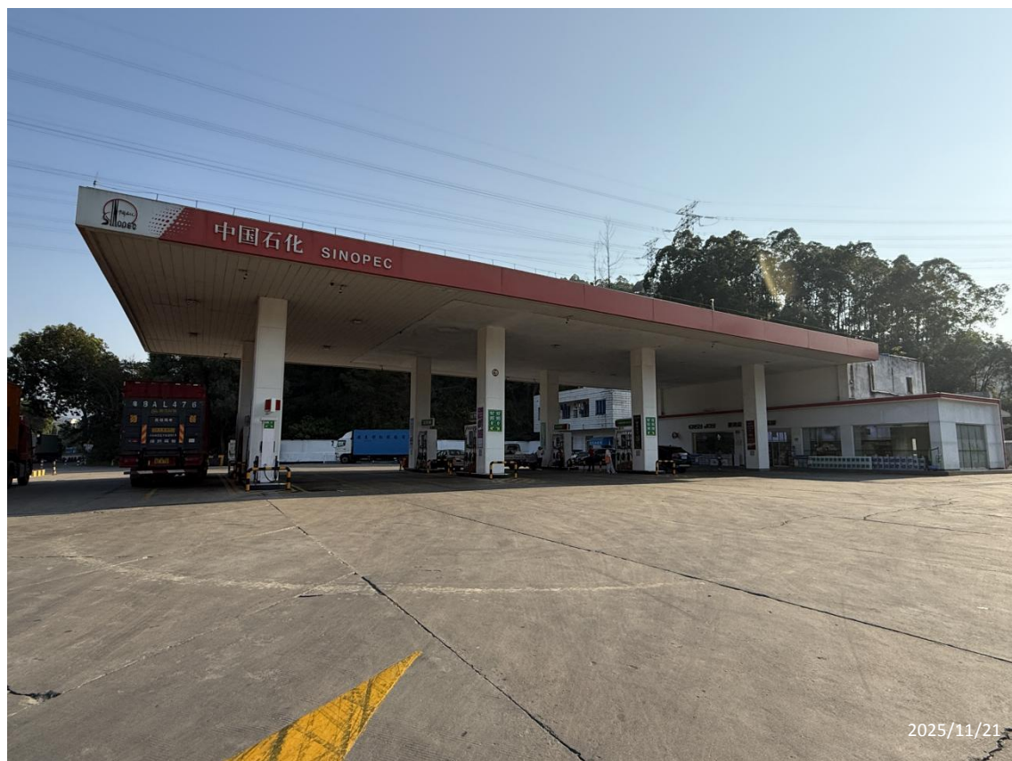
中国石化销售股份有限公司广东东莞常平利丰加油站现场勘察影像：
