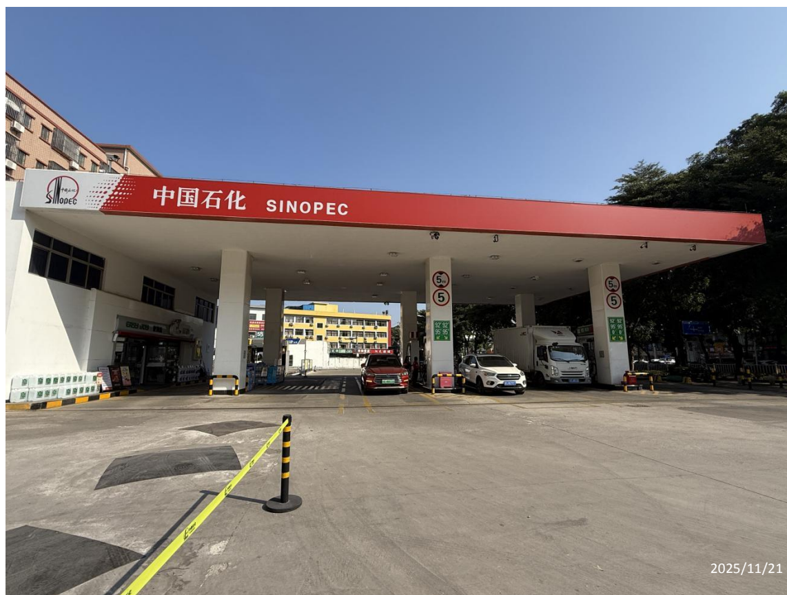
中国石化销售股份有限公司广东东莞常平运通加油站现场勘察影像：
