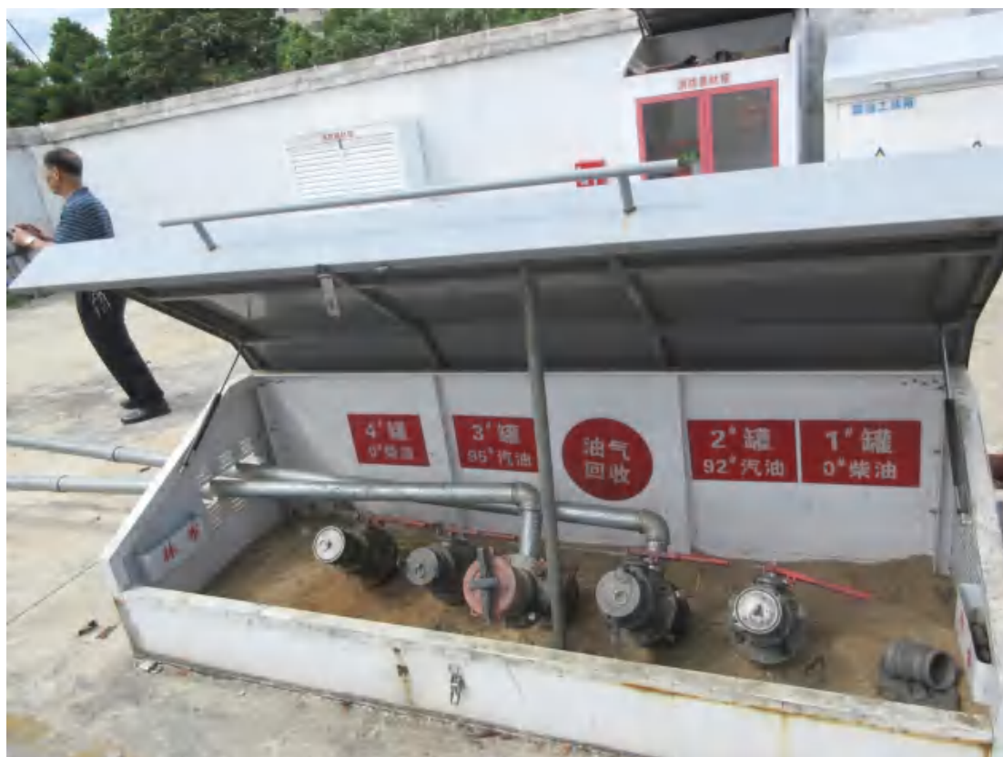
图 4：加油站卸油口照片
