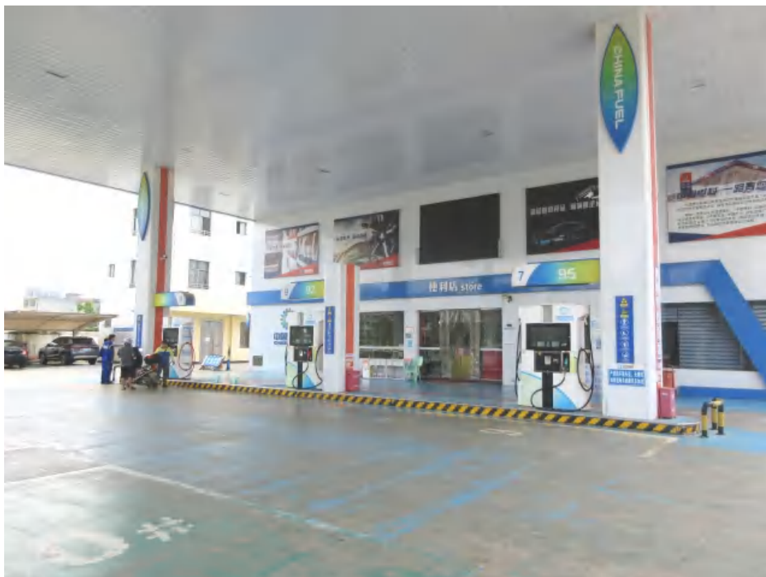
图 3：加油站加油机照片
