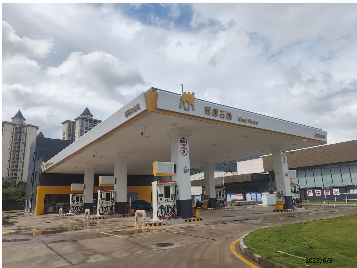
肇庆盈德企业管理有限公司肇庆盈德油站项目现场勘察影像：
