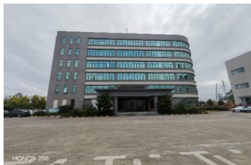
惠州市永盛辉实业有限公司现场勘察照片
