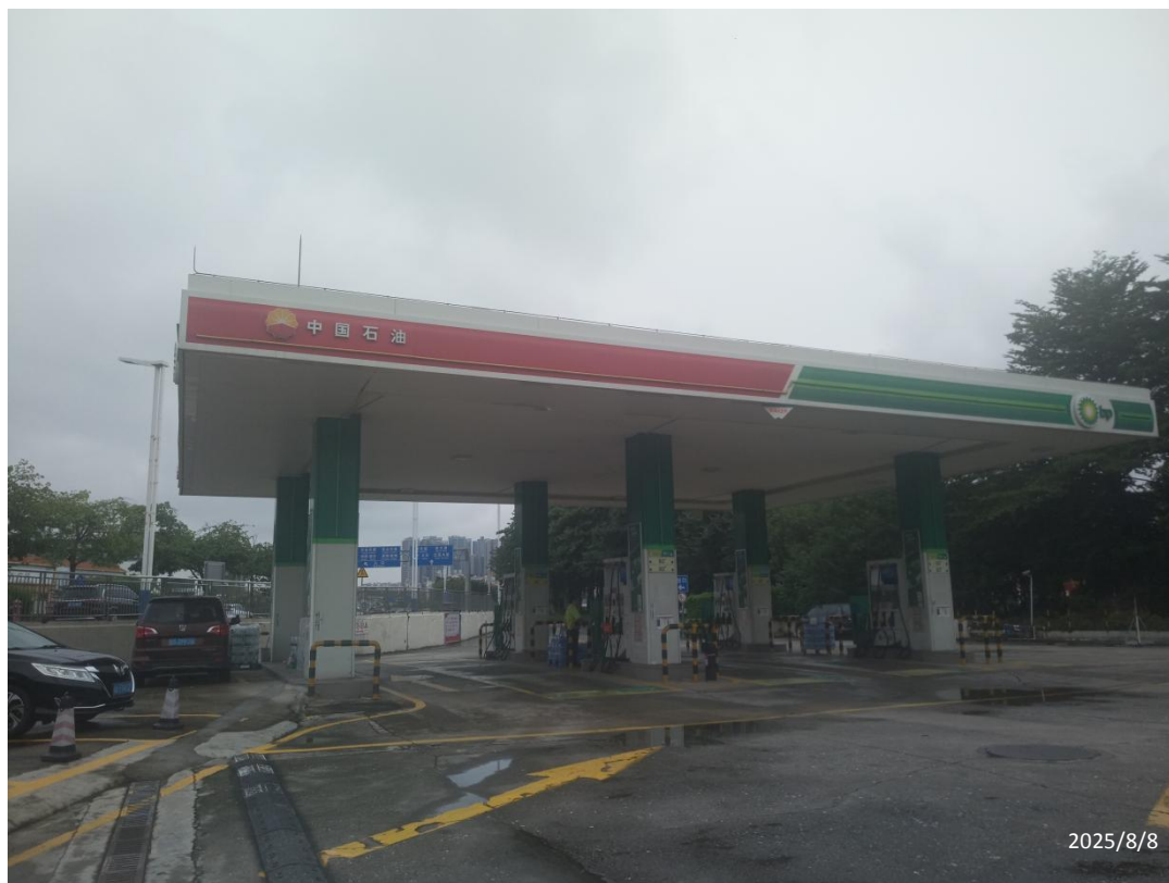
中油碧辟石油有限公司广州迎捷加油站现场勘察影像：
