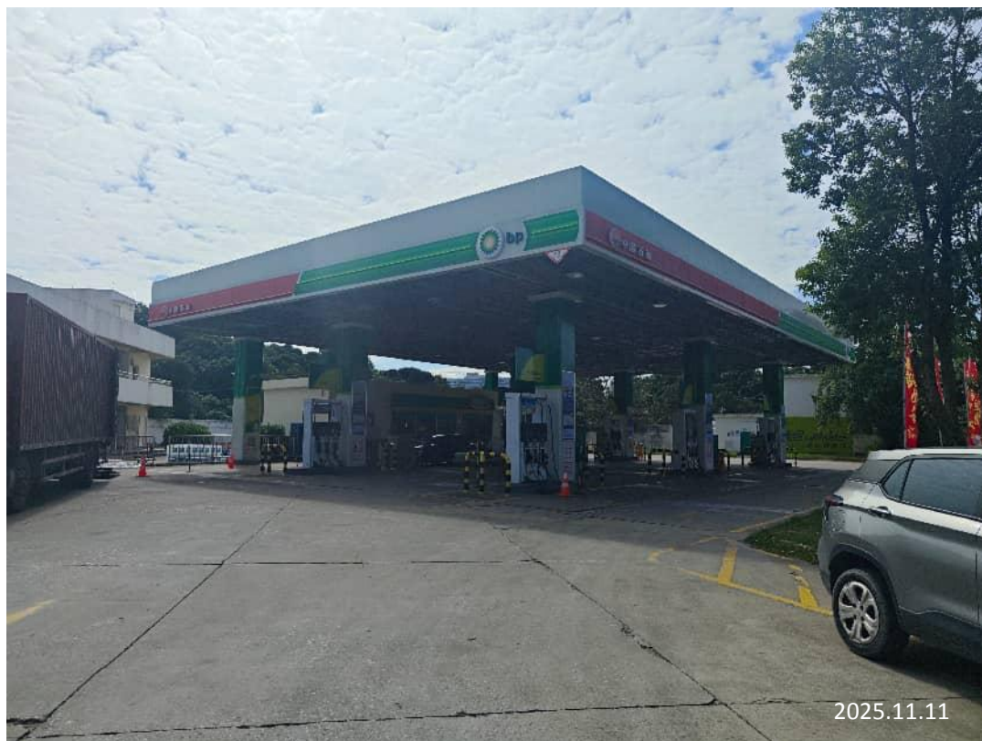
中油碧辟石油有限公司广州凌志加油站现场勘察影像：
