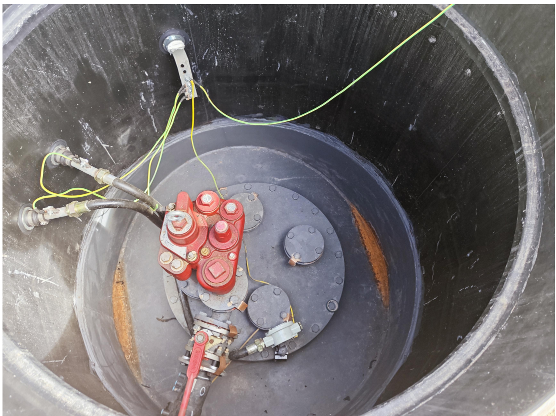
油罐人孔操作井照片
