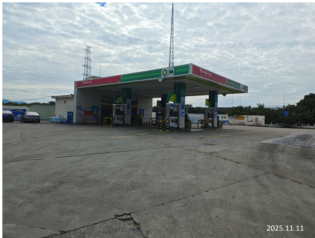
中油碧辟石油有限公司广州北郊加油站现场勘察影像：
