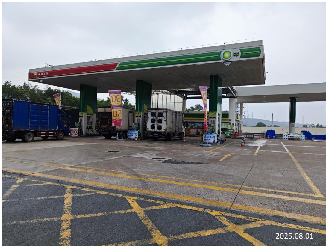
中油碧辟石油有限公司广州西二环高速公路服务区东区加油站现场勘察影像：
