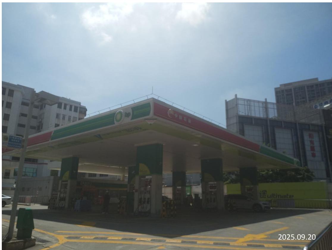
中油碧辟石油有限公司广州广州大道加油站现场勘察影像：
