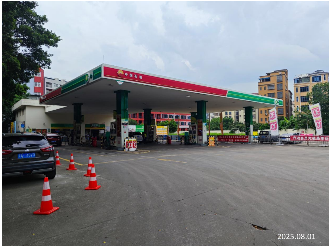
中油碧辟石油有限公司花都迎宾大道加油站现场勘察影像：
