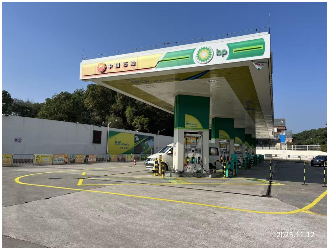
中油碧辟石油有限公司广州元岗加油站现场勘察影像：
