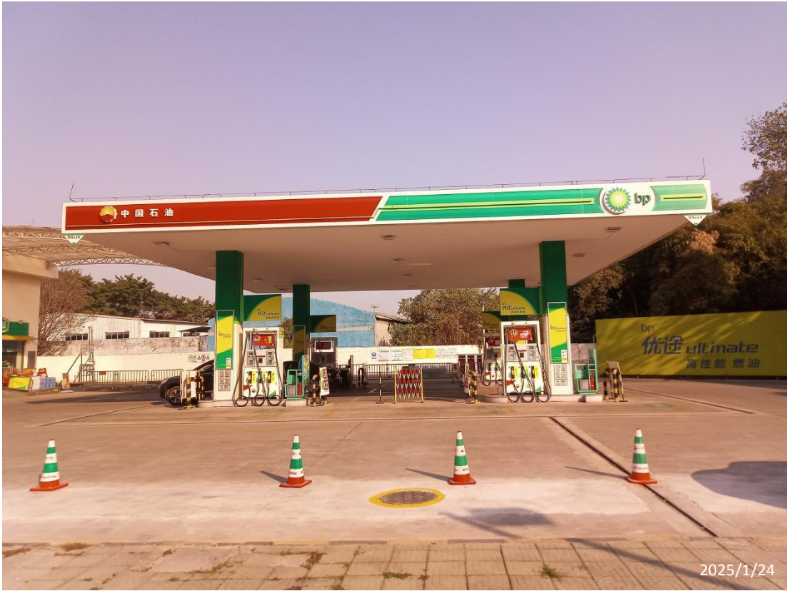
中油碧辟石油有限公司官堂北加油站现场照片
