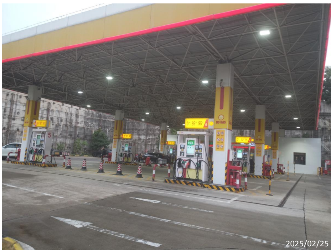
广州新沙加油站有限公司东沙东加油站现场照片
