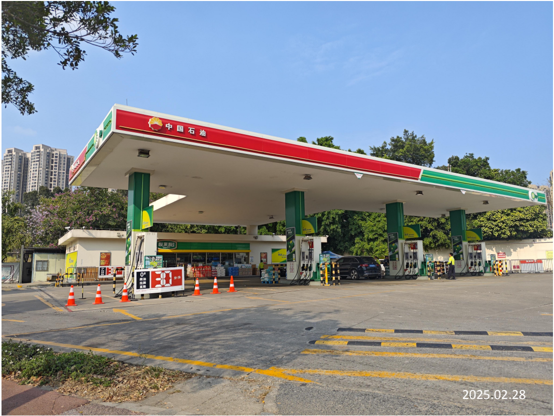
中油碧辟石油有限公司广州慧城加油站现场勘察影像：
