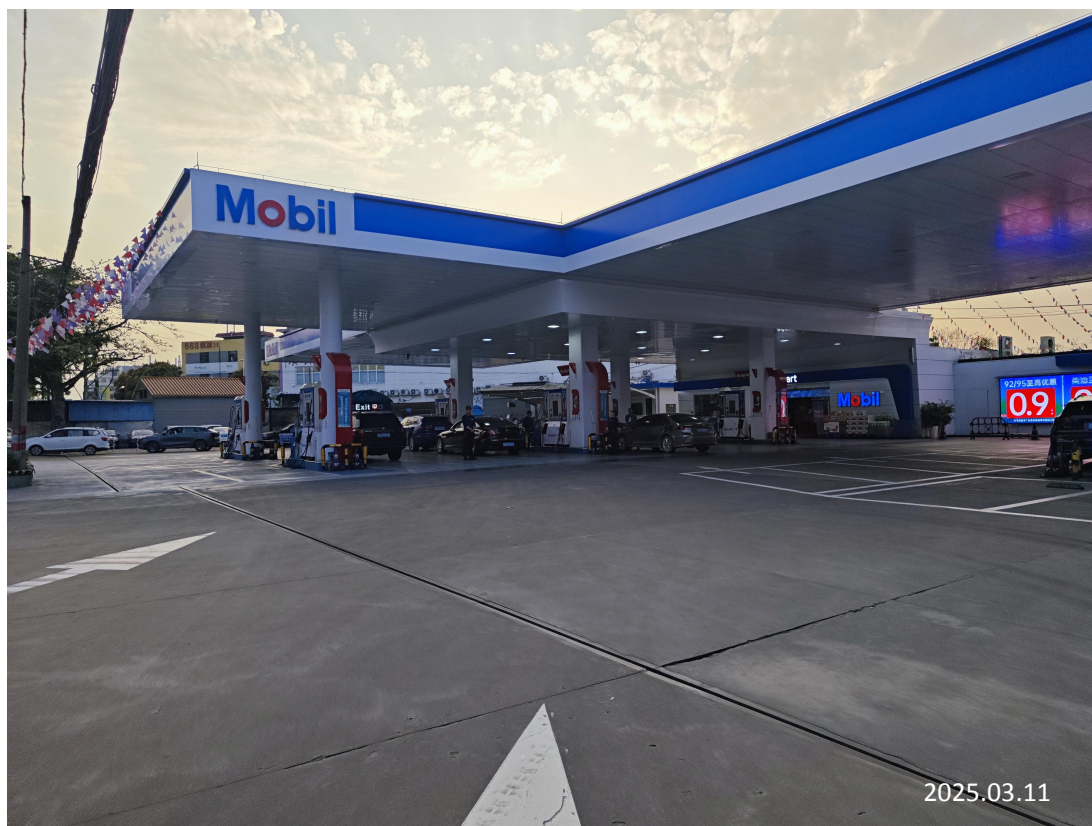
广州市南拓加油站有限公司现场勘察影像：
