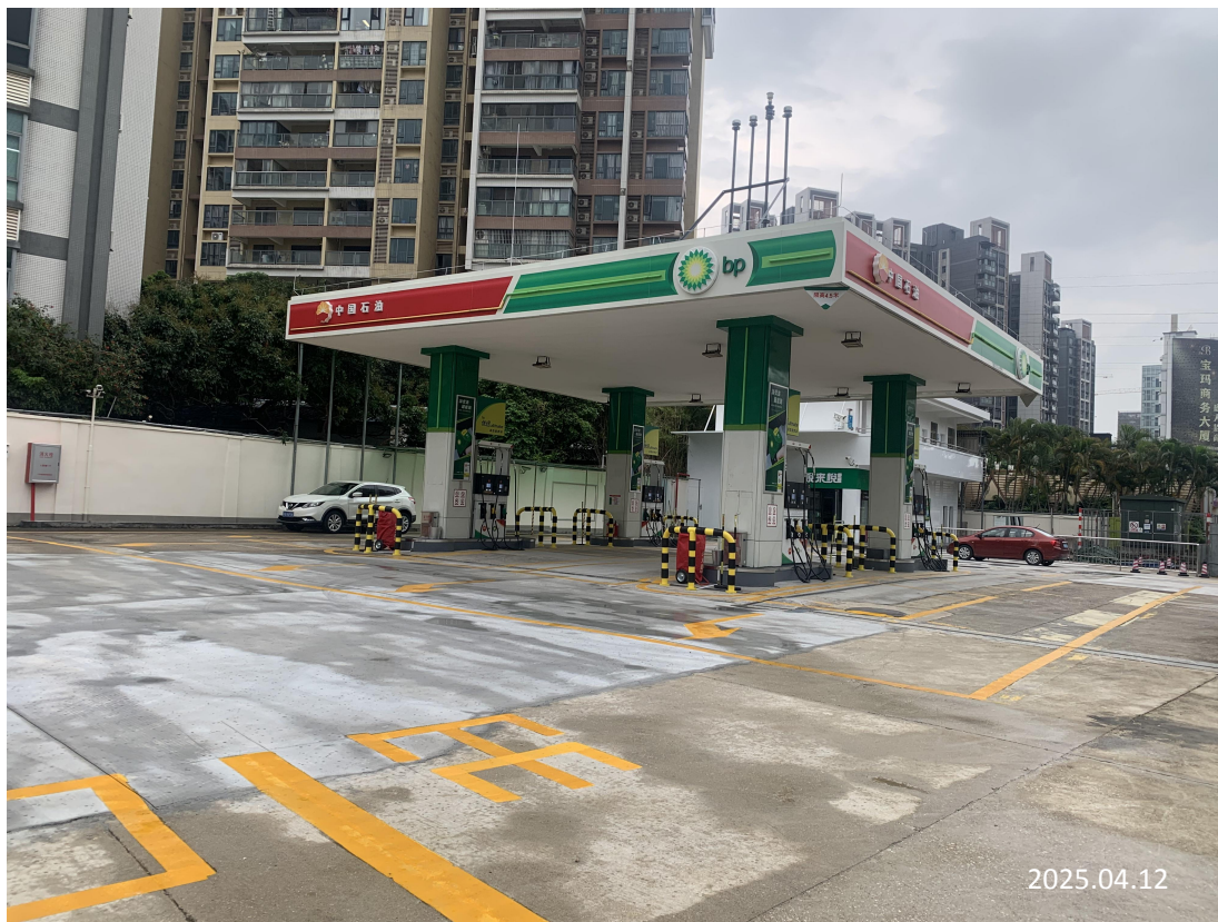
中油碧辟石油有限公司广州驰粤加油站现场勘察影像：
