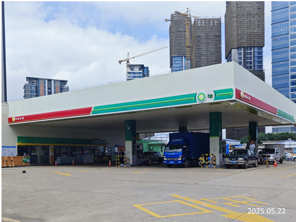
中油碧辟石油有限公司广州钰嘉加油站现场勘察影像：
