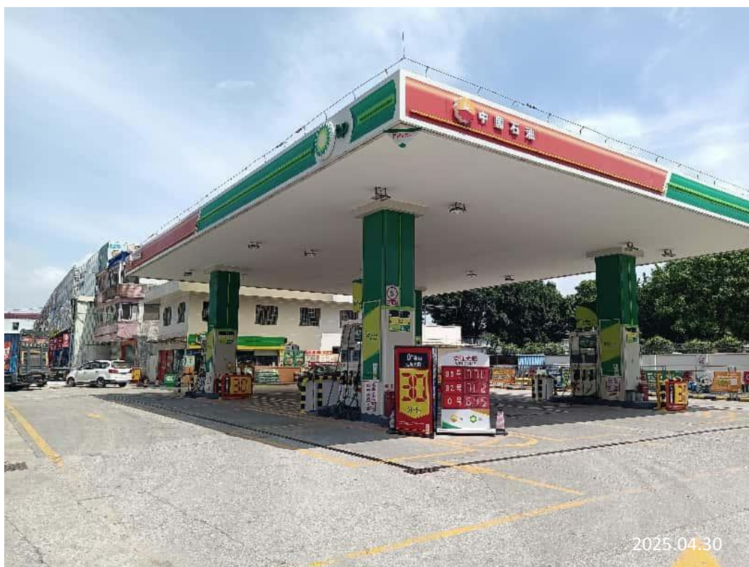
中油碧辟石油有限公司广州鱼珠加油站现场勘察影像：
